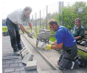
Bau der Stockbahnen
